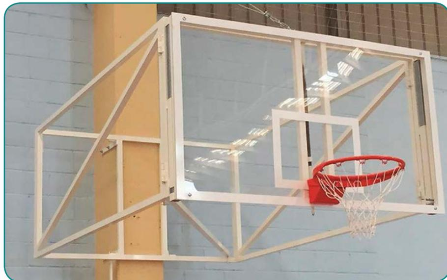
◀ Canasta de 2,5 m de vuelo sujeta a columna mediante soporte metálico y cable tirante.
